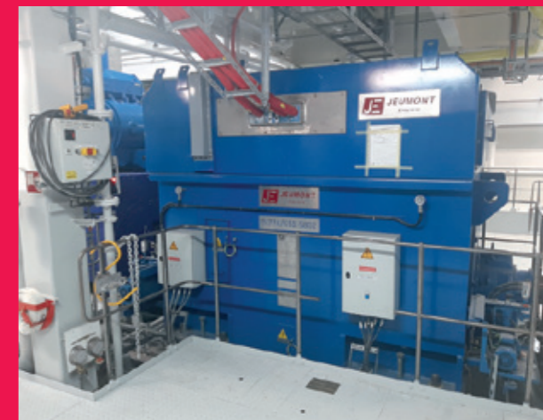
Système de propulsion d'un ferry
