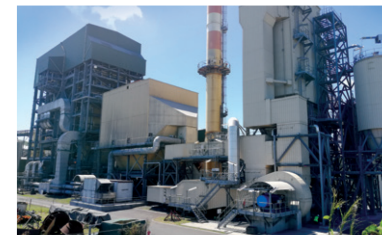
Usine de valorisation énergétique de Bois-Rouge sur l'île de la Réunion
