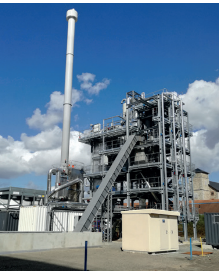
Plateforme Innov'Energy à Nantes
