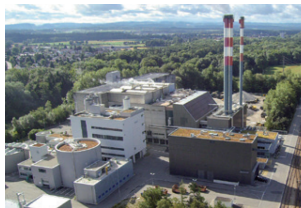
Unité de valorisation énergétique de KEBAG en Suisse
