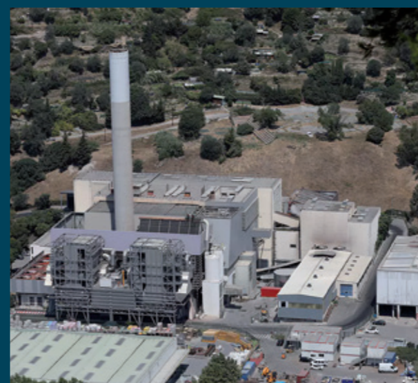
L'unité de valorisation énergétique de Nice
