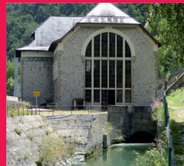
La centrale hydraulique EDF de Combe d'Avrieux dans les Alpes
